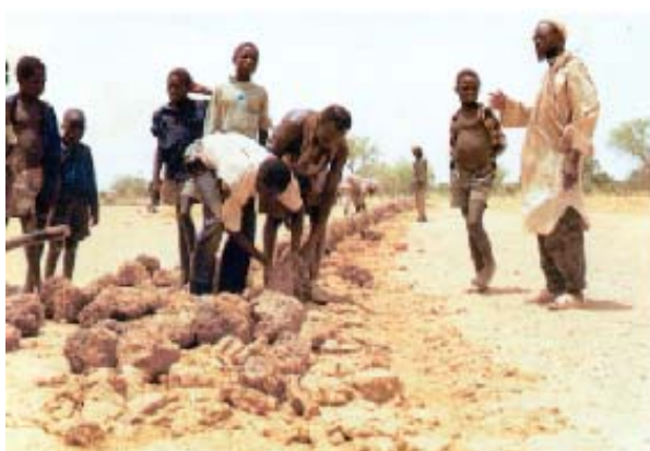
Réalisation d'un cordon pierreux par des producteurs
